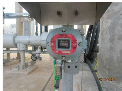
ภาพที่ 2-8 Gas Detector
