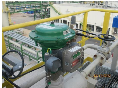
ภาพที่ 2-9 วาล์วระบายความดันที่ท่อเผา/วาล์วฉุกเฉิน
