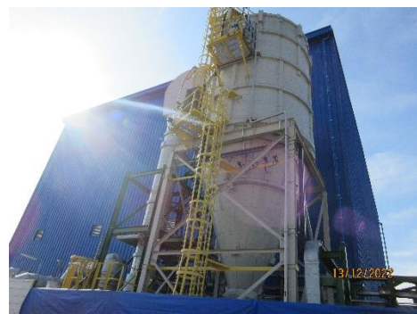
ภาพที่ 2-4 เครื่องดักฝุ่นแบบ Bag Filter
