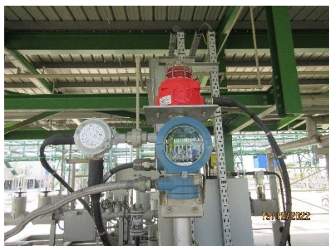
ภาพที่ 2-36 ติดตั้งปลั๊กควาล์วที่ท่อ และเครื่องตรวจวัดอัตราการไหล
