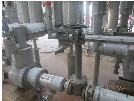
ภาพที่ 2-9 วาล์วระบายความดันที่ท่อเผา/วาล์วฉุกเฉิน
