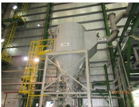
ภาพที่ 2-3 เครื่องดักฝุ่นแบบ Cyclone Separator
