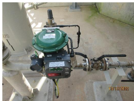
ภาพที่ 2-36 ติดตั้งปลั๊กควาล์วที่ท่อ และเครื่องตรวจวัดอัตราการไหล
