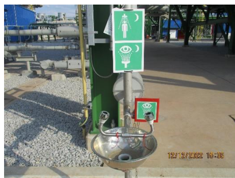
ภาพที่ 2-29 อ่างล้างตาและร่างกายฉุกเฉิน
